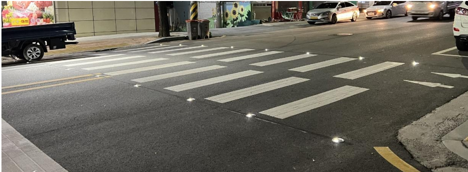
[그림 3] 현장 활주로형 횡단보도 설치 현황
