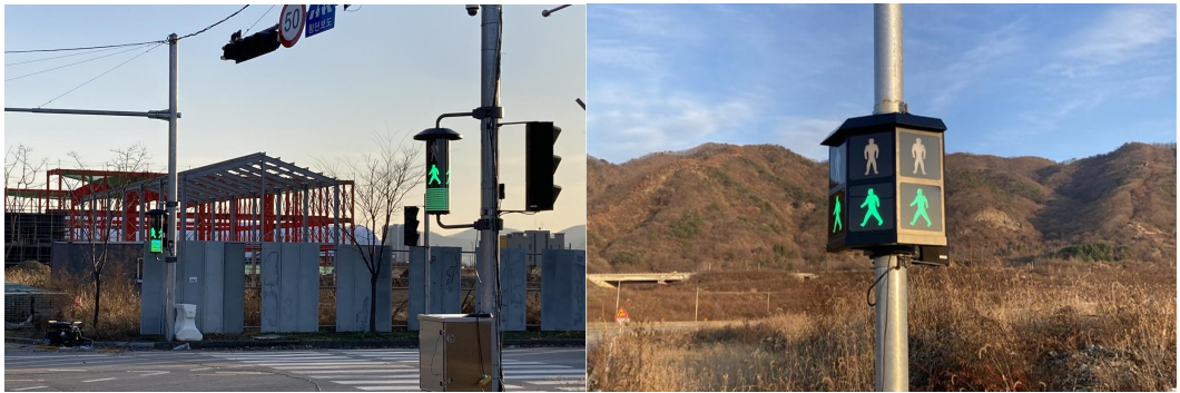
[그림 3] 원통형 보행신호등 시작품의 현장 설치
