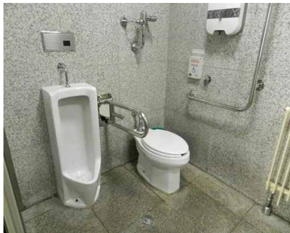
[그림 11] 여성 장애인 화장실 [Fig 11] Female handicapped rest room
