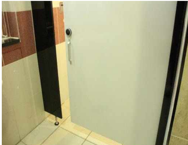
[그림 19] 남성 장애인 화장실 출입문 [Fig 19] Male handicapped toilet door
